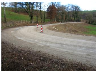
Les travaux de terrassements sont terminés ainsi que la construction du corps de chaussée, la route a été rouverte à la circulation, avant un retour de l'entreprise quand les conditions météorologiques seront optimales pour achever le chantier, probablement début du printemps 2015.
